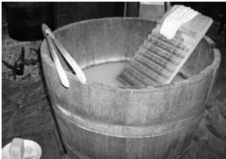
remplissait plusieurs seaux avec de l'eau et on les versait dans la cuve. Pleins d'eau, ils étaient très lourds. Dans la cuve, on ajoutait des cristaux de carbonate de soude. Le linge trempait toute la nuit.
